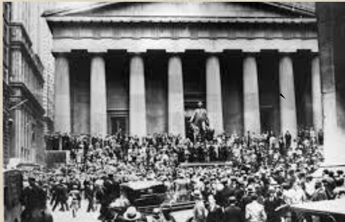
Fig.31. Crack del 29 en E.E.U.U.
